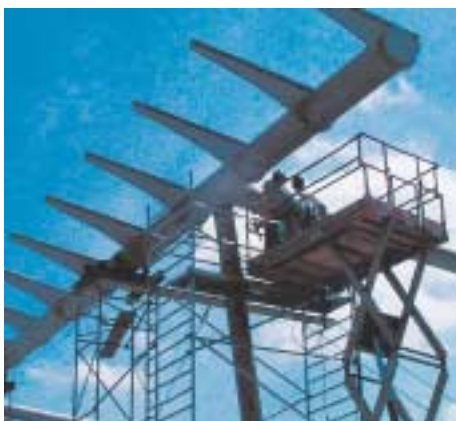
Die Träger für das Glasdach werden montiert.
