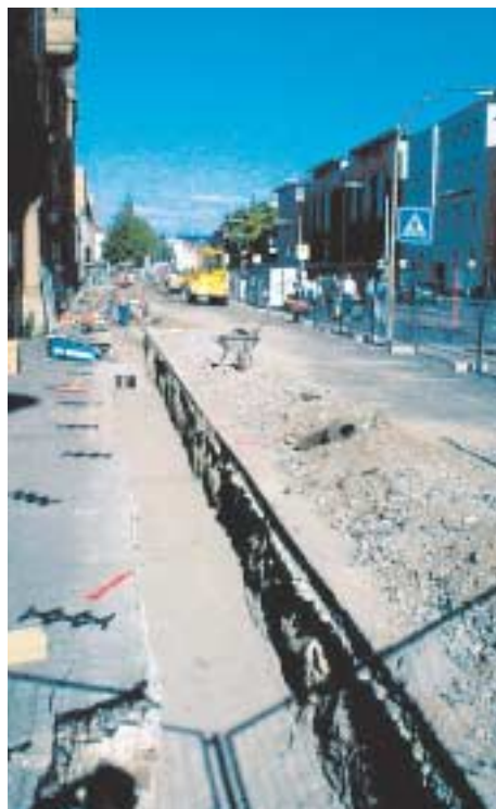
In der Bahnhofstraße wird alles für die Verlegung der Gleise vorbereitet.
