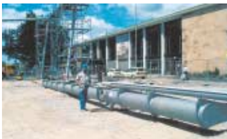
Witterungsbeständig: die Träger für das Glasdach auf dem Bahnhofsvorplatz.
