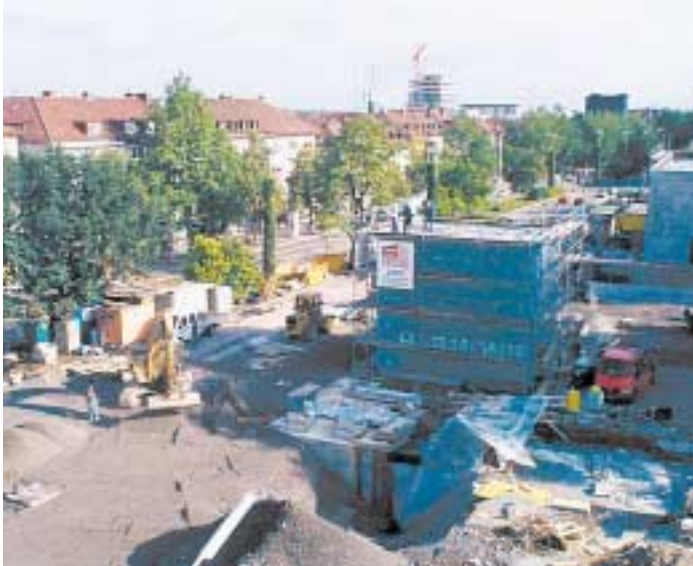
Noch eingehüllt: der neue Fahrstuhl zur Tiefgarage Harmonie.
