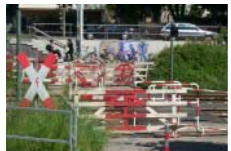
Der alte Bahnübergang wird zurückgebaut.
