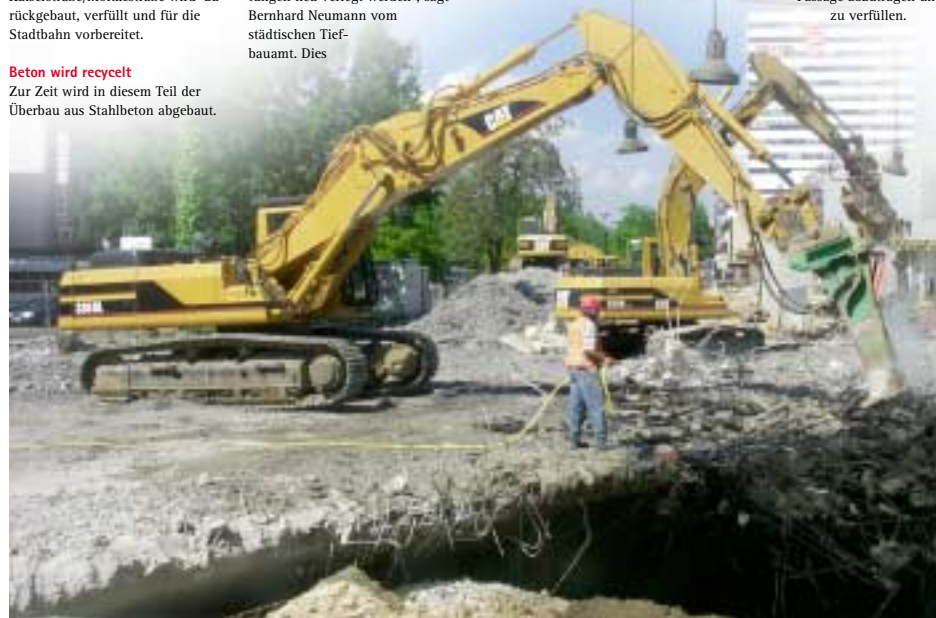
Die Unterführung an der Kreuzung Allee/Kaiserstraße wird abgetragen, verfüllt und für die Stadtbahn vorbereitet.
