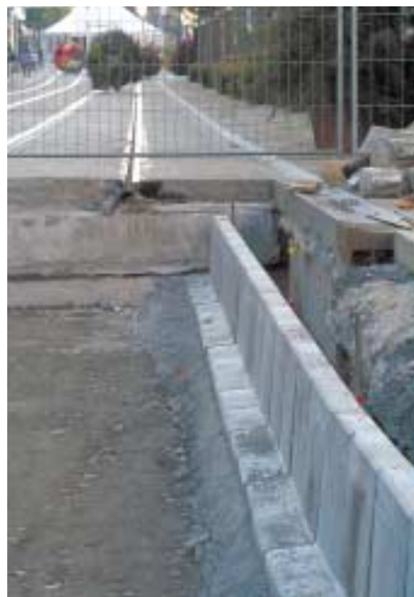
Straßenprofil mit Gleisen und Unterbau
